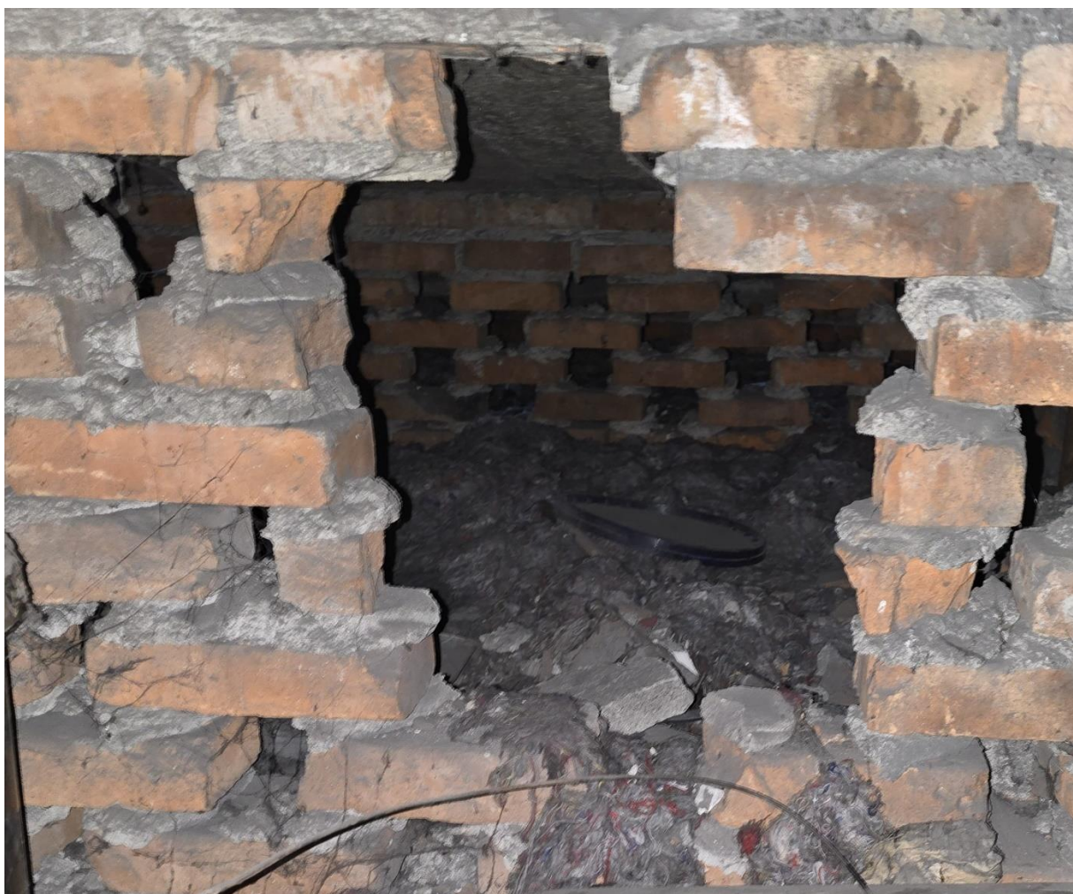
Stropodach wentylowany- przestrzeń wentylowana
